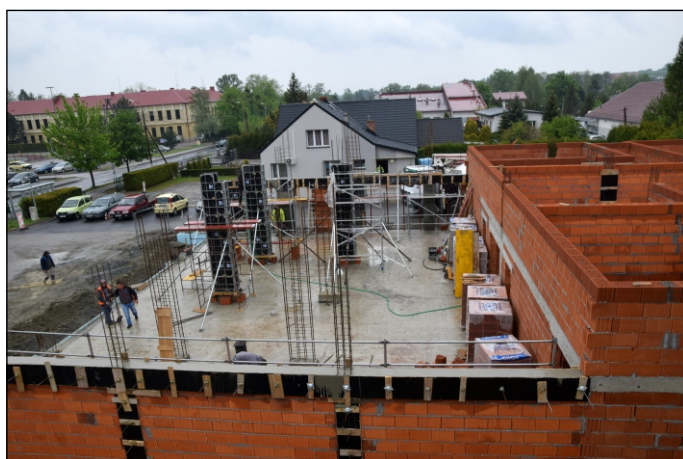
Budowa strażnicy OSP i rozbudowa Urzędu Gminy
