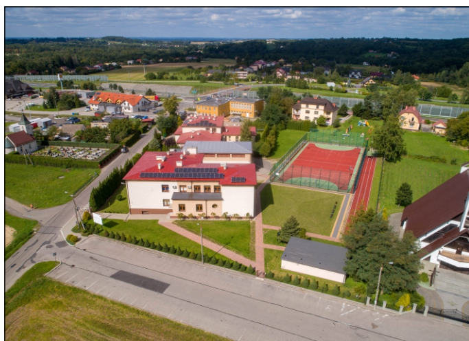
Rozbudowa szkoły w Świętoszówce
